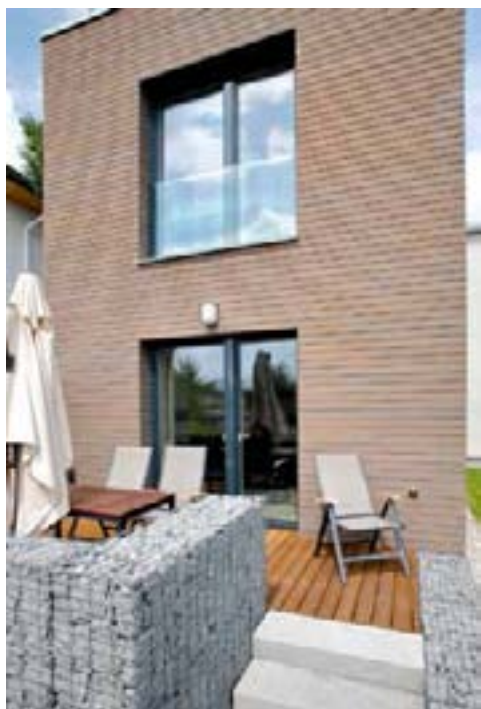
Zahradní trakt, dvoupodlažní hmota s plochou střechou, s velkými prosklenými plochami a s horizontálním dřevěným obložení
