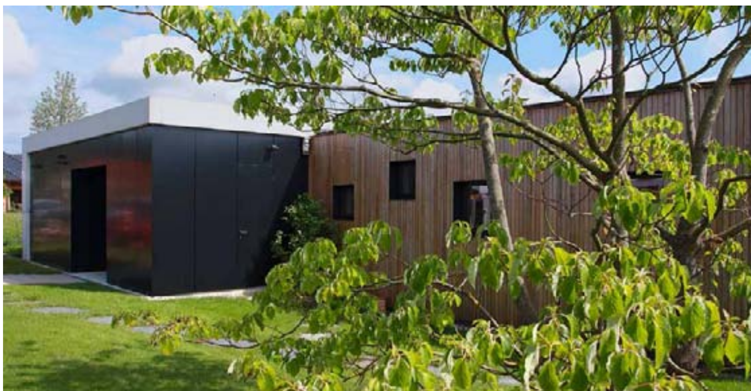
Ložnicová část domu má provětrávanou dřevěnou fasádu z cedrových latí, v severní vstupní části je použit černý alucobond
