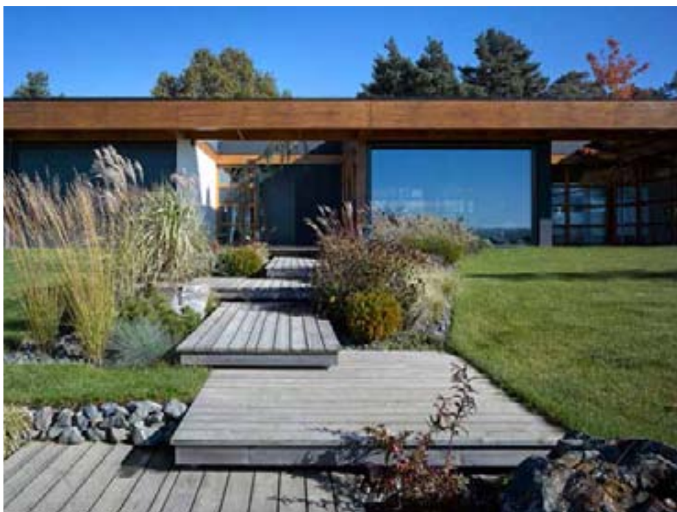
K hlavnímu vstupu, zapuštěnému do hmoty domu, vede přístupová cesta vytvořená z dřevěných terásek (z thermowoodu). Velká nečleněná prosklená plocha otevírá výhled z obývacího pokoje. Velkou a poměrně členitou stavbu po obvodu lemuje a tvarově sjednocuje „límeč“ z borovicového dřeva
